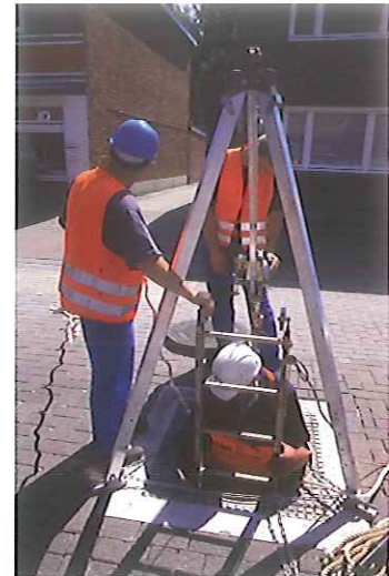
Le garde de sécurité entretient la communication avec la personne qui se trouve dans l'espace confiné.
