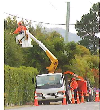
Élévateur à nacelle sur camion
