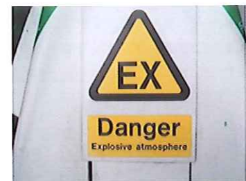
Panneau d'avertissement d'une zone à risque d'explosion
